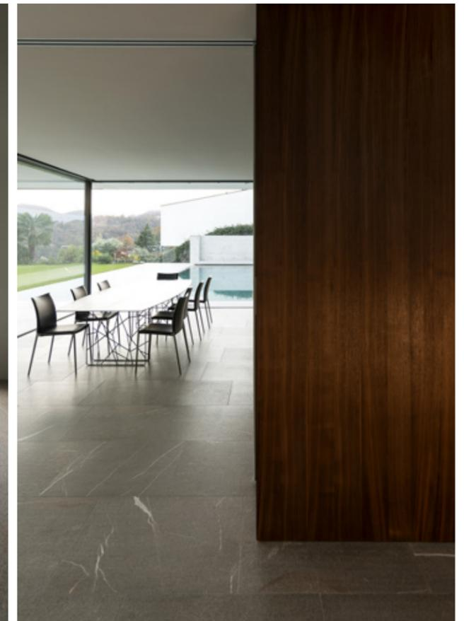
Lastre di Pietra Piasentina "a correre" con larghezza 60 cm, spessore interno 2 cm e esterno 3 cm. / Piasentina Stone tiles, laid in a random running bond pattern, tile size 60 cm. Edge thickness 3 cm, inner thickness 2 cm.
